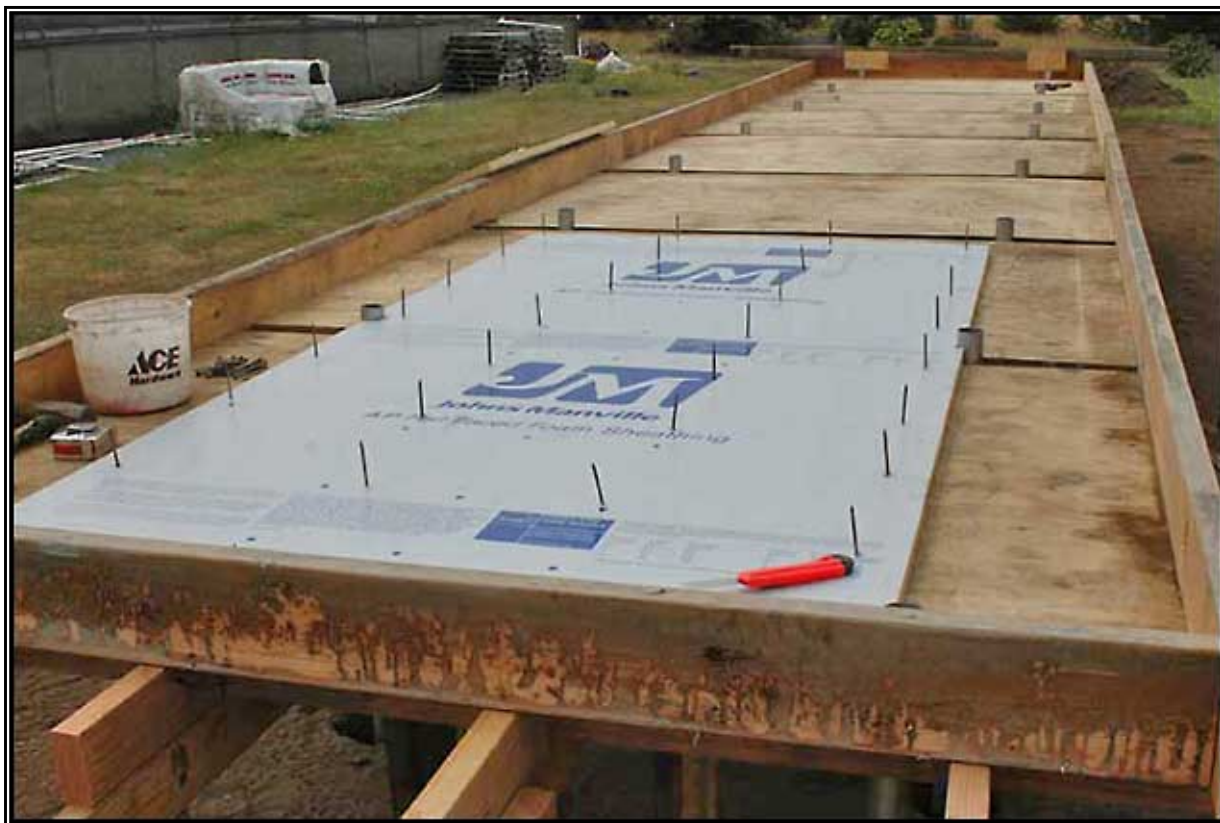
Construction d'une nouvelle unité tout en béton. Coffrage avec isolation.
